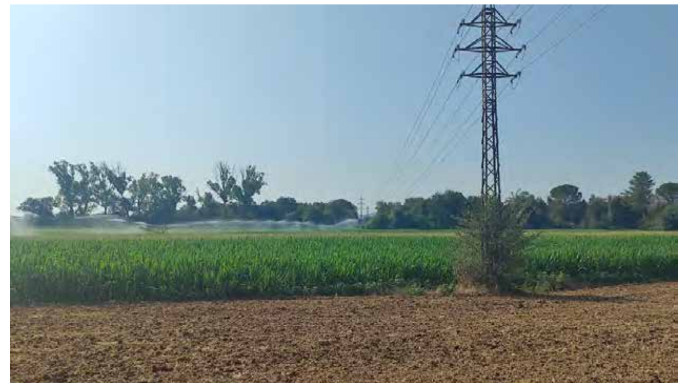
Foto4. Suport metàl·lic T-18 a retirar, substitució de línia aèria i suport T-19 de fons.
