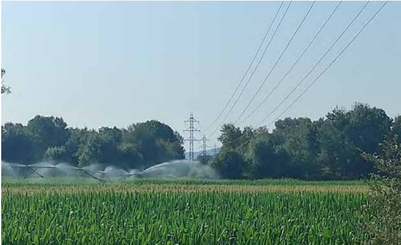
Foto5. Suport metàl·lic T-19 existent i ubicació del nou suport T-18.
