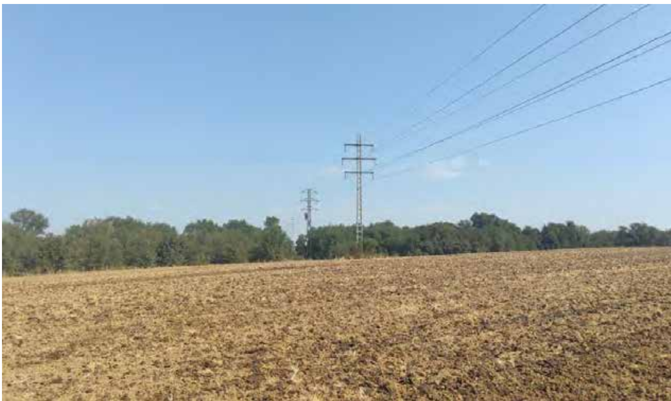
Foto6. Suport metàl·lic T-17 a retirar, T-16b al fons, i ubicació del nou suport T-17
