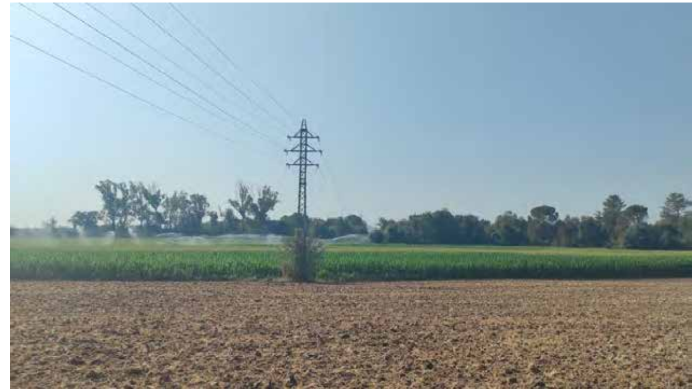
Foto3. Suport metàl·lic T-18 a retirar i substitució de línia aèria.
