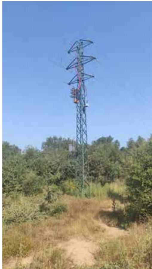
Foto1. Suport metàl·lic existent T-16b on s'inicia la substitució de la línia aèria.
