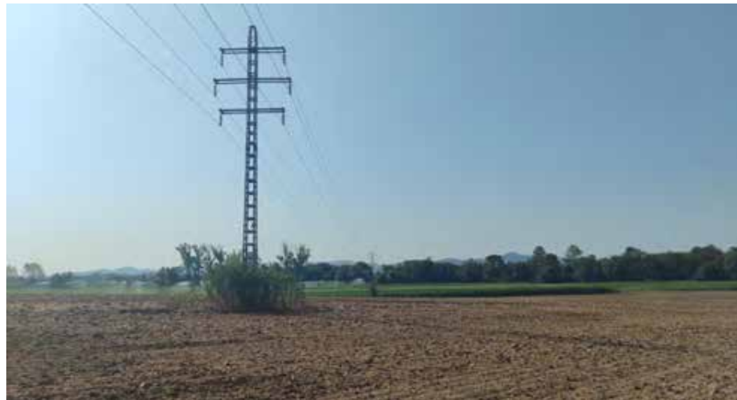
Foto2. Suport metàl·lic T-17 a retirar, substitució de línia aèria i ubicació del nou suport T-17
